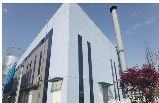
G01 综合动力楼
