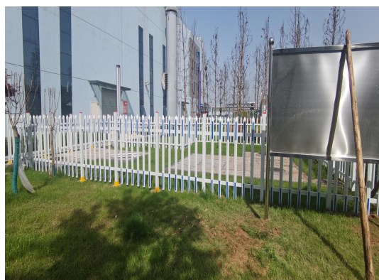
事故池及初期雨水池
