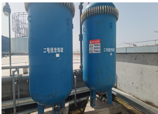
盐酸他喷他多生产装置泄爆罐
