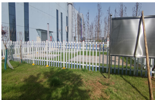
事故池、初期雨水池（地埋）
