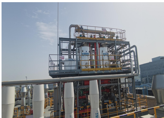
工艺废气酸洗/碱洗+水吸收塔+活性炭吸附+蒸汽脱附装置及标识牌
