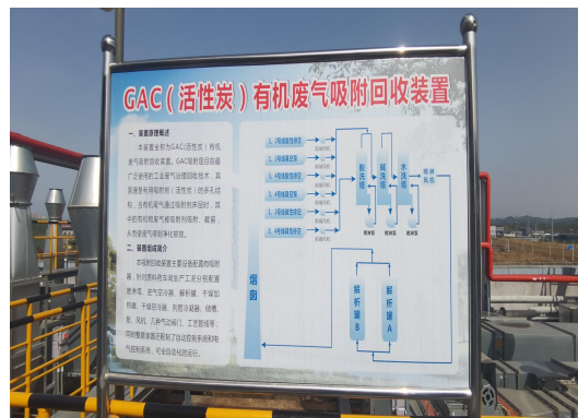
工艺废气酸洗/碱洗+水吸收塔+活性炭吸附+蒸汽脱附装置及标识牌
