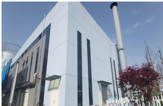
锅炉房及锅炉废气排气筒 DA003
