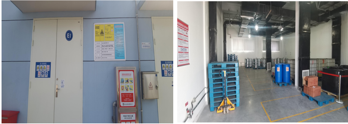
危险废物暂存间
