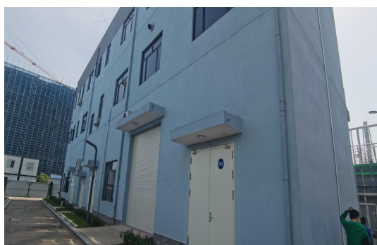
G03 污水处理设备房
