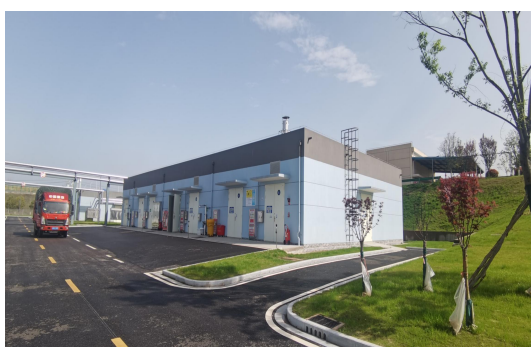
G02 固体废物暂存间
