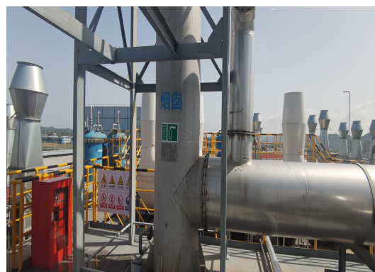
原料 1 车间废气排气筒 DA001 及标识牌
